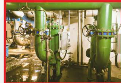
KARDEMİR SDM4 yatırımı kapsamında 28 km yer altı ve yer üstü borulama yapılmıştır.
