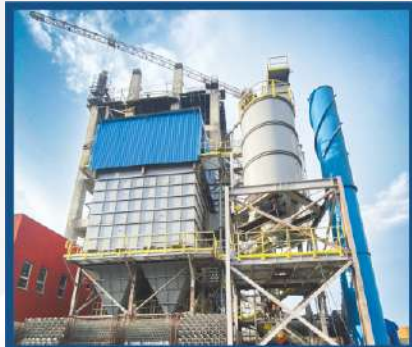
İSDEMİR KOK - Toz toplama sistemi imalatı ve montajı
