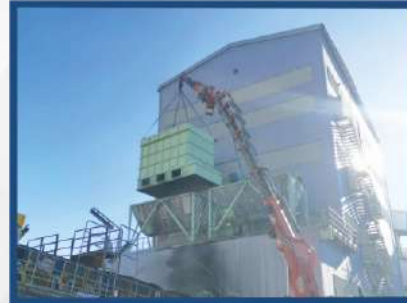
ENERJİSA TUFANBEYLİ 2 Adet Toz Toplama Sistemi Anahtar Teslim Tamamlanmıştır.
