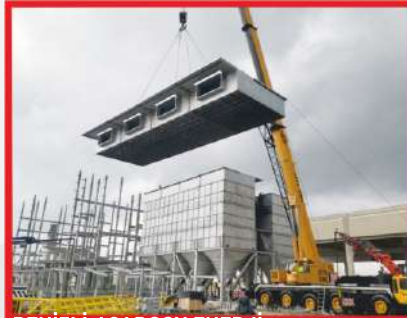
DENİZLİ ACARSOY ENERJİ Toz Toplama Sistemi İmalat ve Montajı Yapılmıştır.
