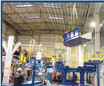
YORGLASS Cam tesisi ve montajı işleri.
