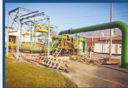
KARDEMİR Merkezi arıtma kapsamında ekipman ve borulama montajı yapılmıştır.
