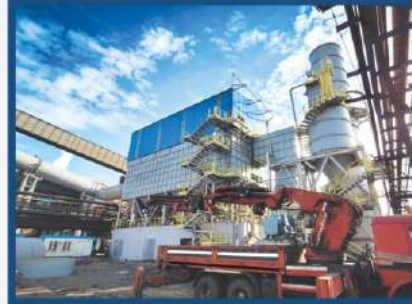
ERDEMİR Toz Toplama Sistemi İmalat ve Montajı Yapılmıştır.
