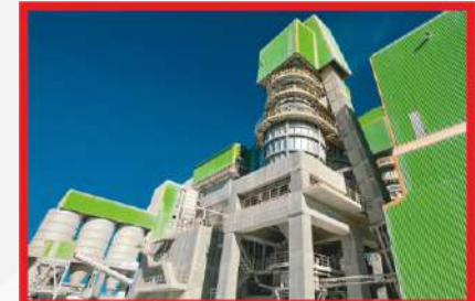
TOŞÇELİK KİREÇ FIRINI Tosyalı Tesisine 2 adet 650 ton/gün kapasiteli kireç tesisi ve 1 adet 650 ton/gün kapasiteli dolomit tesisi imalat ve montajı yapılmıştır.
