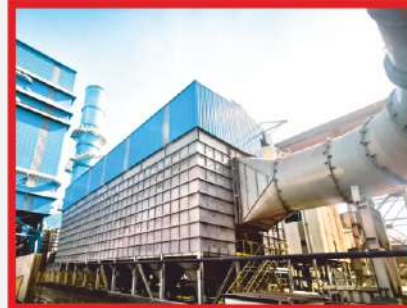
İSDEMİR 1. Y.F Toz Toplama sistemleri yapım işleri.
