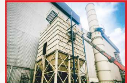
ÇOLAKOĞULLU METALURJİ Toz toplama sistemi imalatı ve montajı yapılmıştır. Yeni yatırımda filtre tek parça alınır yer değiştirilmiştir.
