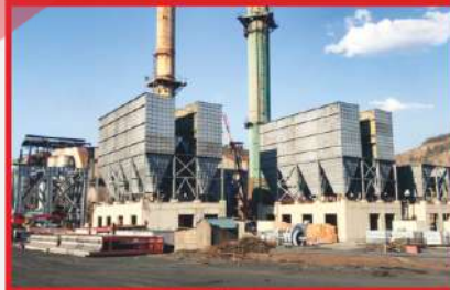
KARDEMİR 1.200.000,00 m 3 /h toz toplama sistemi imalat ve montajı yapılmıştır.
